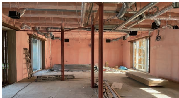
内部の断熱材吹付とサッシ取付工事中です。
