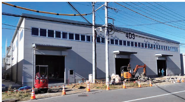
工場全景。竣工に向けて内装工事施行中です。
