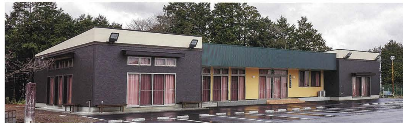
公民館全景 外壁の大きな投光器は地元消防団の夜間訓練で使用する。
