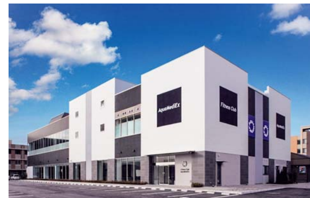
①商業施設(フィットネスクラブ)②茨城県水戸市③スイコウアセット④新築設計監理⑤2009年12月⑥双葉建築⑦新栄電気通信工業⑧映飯島工業⑨東芝⑩プール工事:ニッコン
