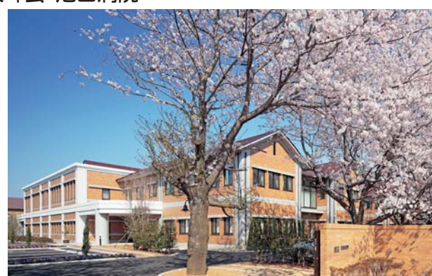
①病院②茨城県龍ヶ崎③医療法人社団八峰会④改築設計監理⑤2010年12月⑥安藤建設(現安藤・間)⑦六興電気⑧映飯島工業
