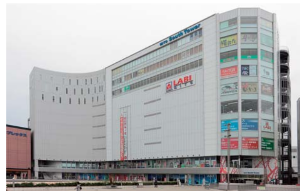
①複合ビル②茨城県水戸市③310・2号特定目的会社④新築設計監理⑤2008年10月⑥安藤建設(現安藤・間)⑦関電工⑧⑨高砂熱学工業
