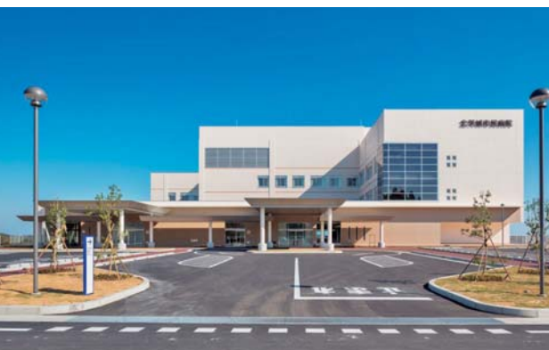
①病院②茨城県北茨城市③北茨城市長④新築設計監理⑤久米・エイプラスJV⑥2014年3月⑦清水建設⑧関電工⑨新菱冷熱工業⑩日立ビルシステムズ
