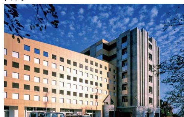
①共同住宅②茨城県水戸市③個人④新築設計監理⑤2006年8月⑥清水建設
