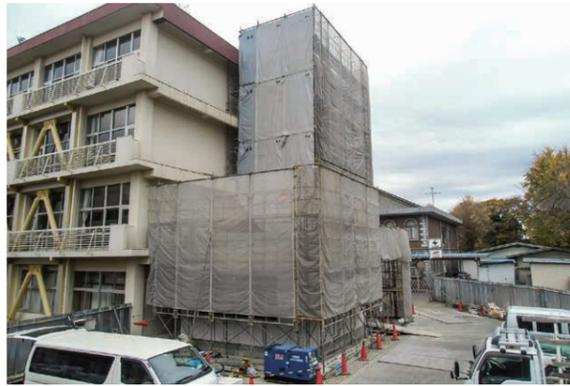
外壁工事中。外壁にはALCと呼ばれる軽量気泡コンクリートパネルを使用。
