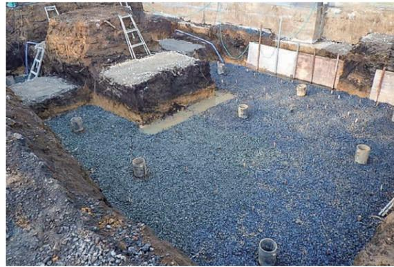
基礎掘削を行っており、次は基礎配筋の工程に入っていきます。
