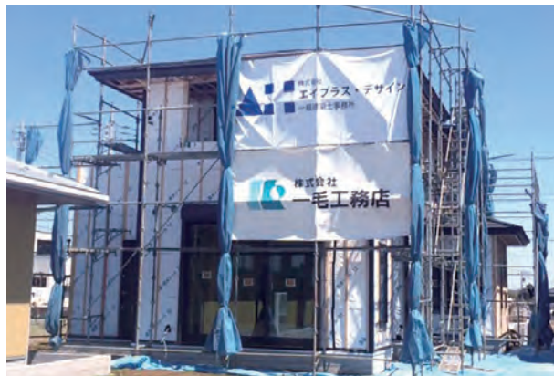
外壁の工事が着々と進む現場
