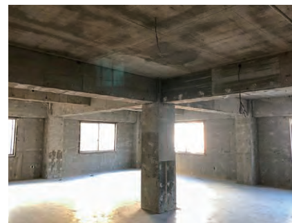
既存の仕上げを解体し、建物の構造のみを残しました。 ここからどういう風になるのか、完成報告をお楽しみに！
