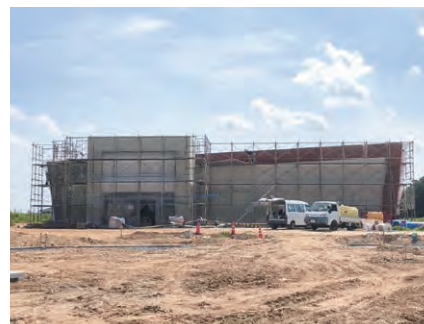
外壁塗装工事中。 写真左側が塗装前、右側が塗装後です。
