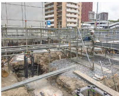
基礎工事のための仮設足場を組み立て中です。
