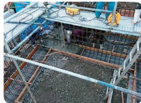
基礎コンクリート打設状況
