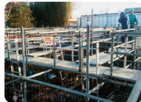
基礎配筋確認状況
