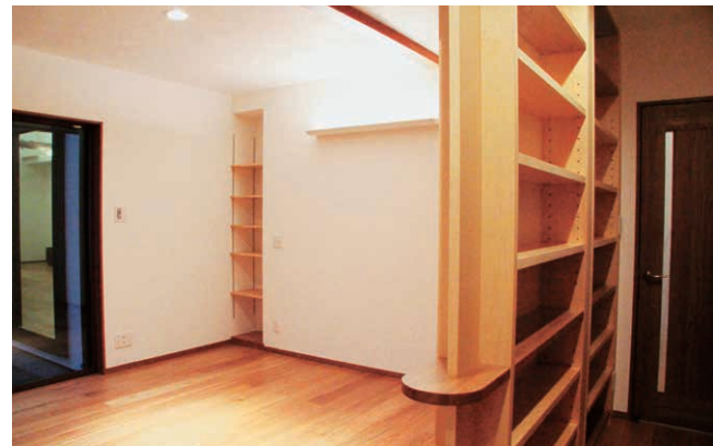
壁・天井は、ドイツ本しっくい塗りとし、空気環境に配慮しました
