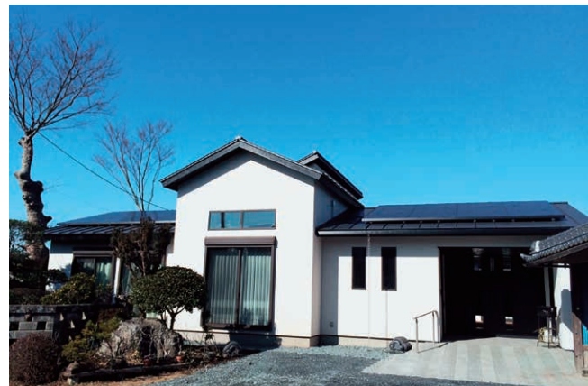
モノトーンの外観は、既存の建物とやさしく調和している
