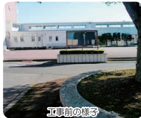
工事前の様子
