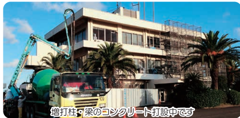
増打柱・梁のコンクリート打設中です
