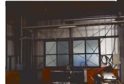
プレースで補強することで、地震に強い建物になりました。
