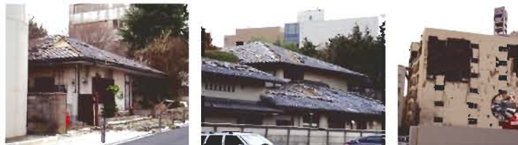
* 茨城県内～水戸市内でも多くの家屋損壊がありました。
